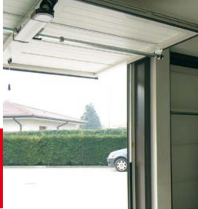
Ouvre-porte basculant puissant et silencieux permettant d'ouvrir les portes basculantes à contre-poids de tous les types, dimensions ou poids, grâce à la possibilité d'agir sur le circuit hydraulique interne et à la facilité de montage des supports même sur des installations préexistantes.
