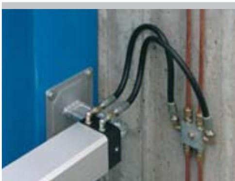
Connexion sur le bloc de dérivation avec raccords à 6 voies
